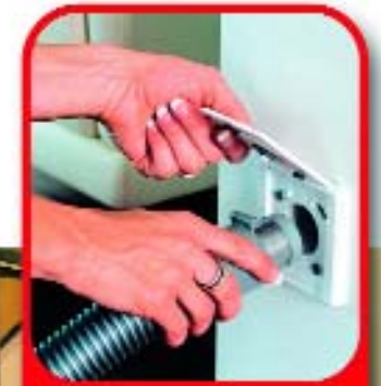
Das zentrale Staubsaugersystem leitet die Abwärme und Staubpartikel in jedem Zimmer durch ein Rohrsystem hinter der speziellen Steckdose zum Auffangbehälter. Späni
